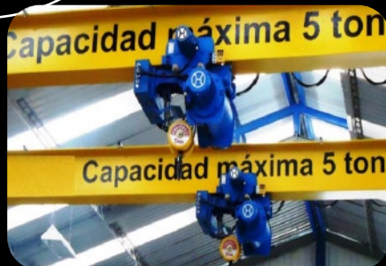
Mantenimiento y reparación de Polipastos.
