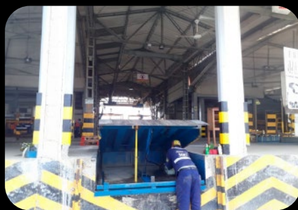
Mantenimiento y reparación de Plataformas Niveladoras
